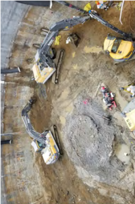
Caisson Excavation -30' EL to -34' EL
