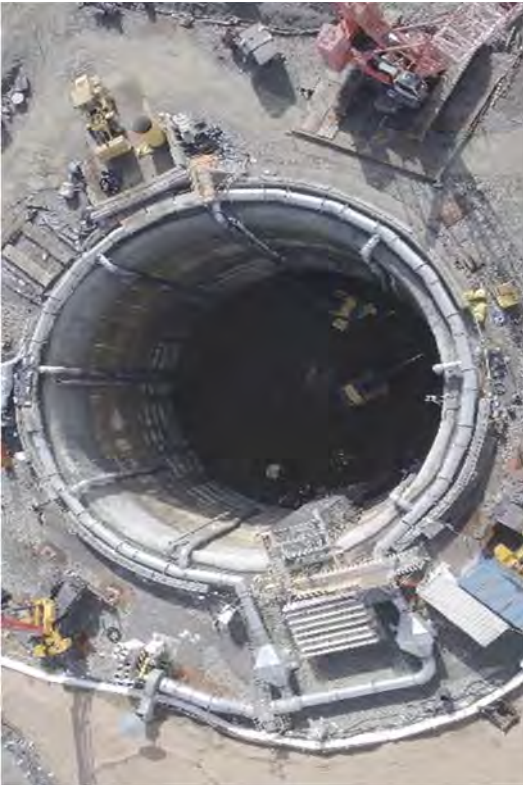
Caisson Excavation -70' EL to -76' EL
