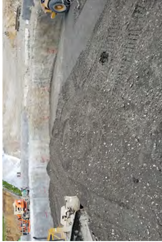
Structural backfill -0.5 / 1.5.
