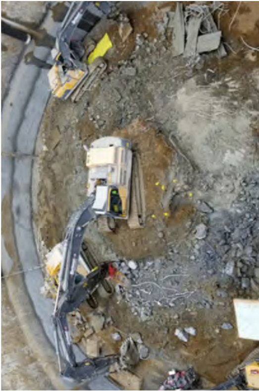
Caisson Excavation -40' EL to -46' EL
