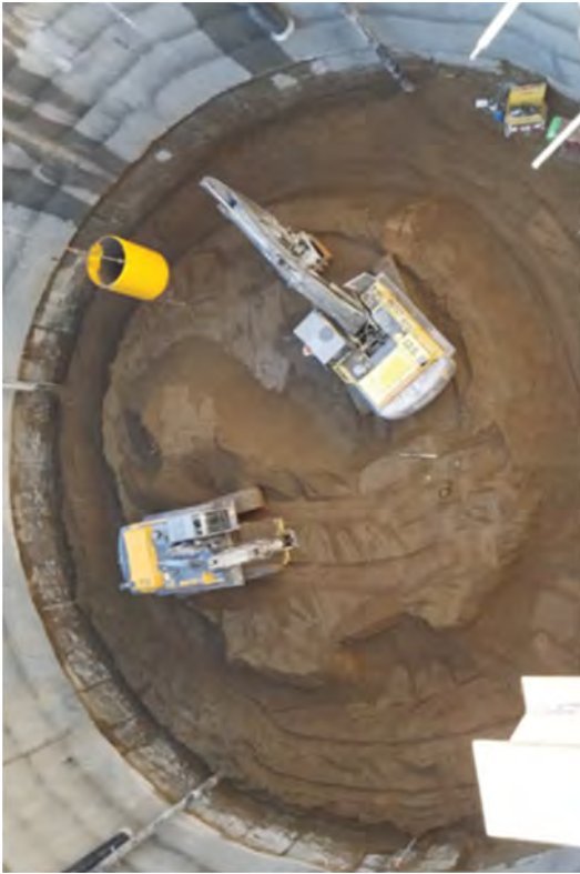
Caisson Excavation -66' EL to -70' EL
