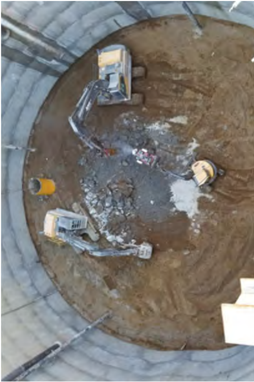
Caisson Excavation -70' EL to -76' EL
