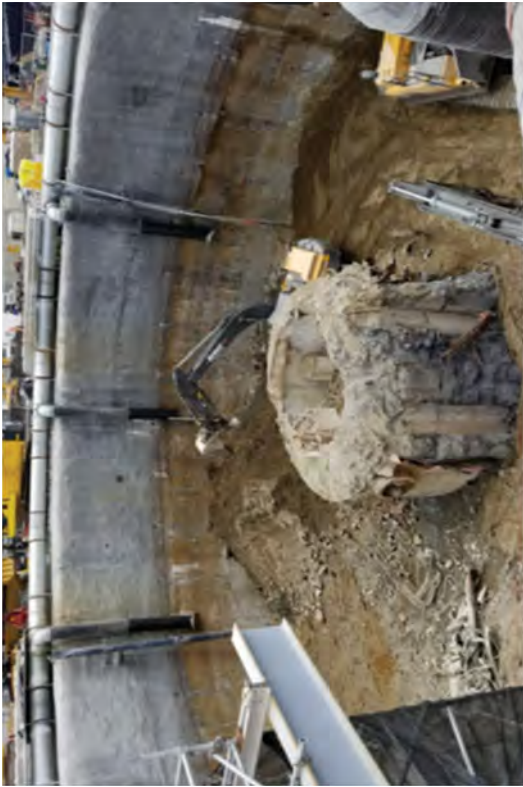
Caisson Excavation -30' EL to -34' EL
