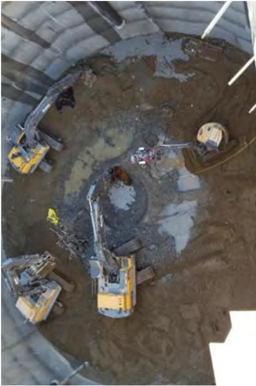
Caisson Excavation -58' EL to -66' EL
