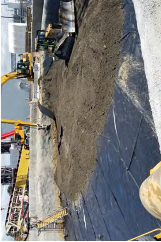
Structural backfill -0.5 / 1.5.
