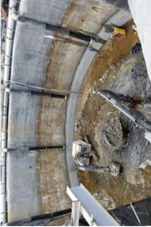
Caisson Excavation-34' EL to -40' EL
