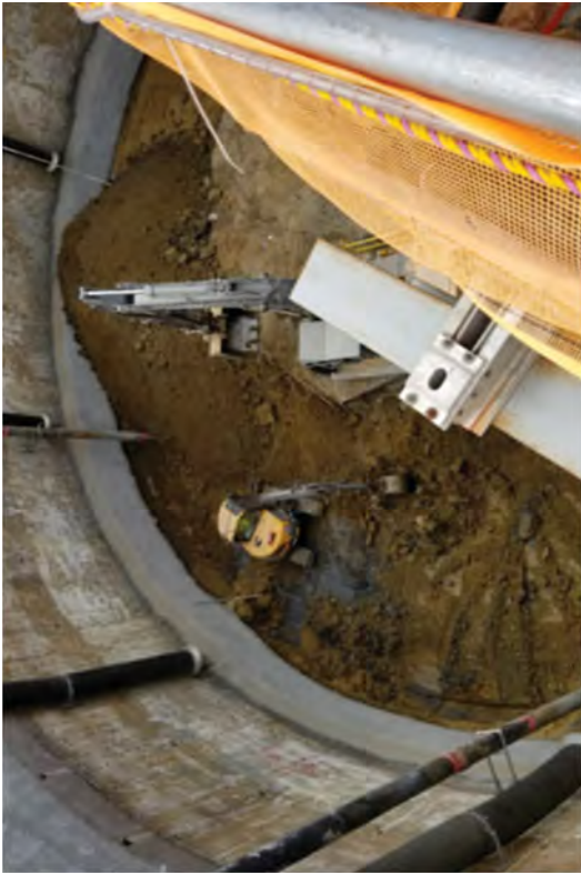
Caisson Excavation -40' EL to -46' EL
