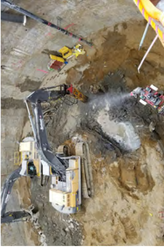
Caisson Excavation-34' EL to -40' EL
