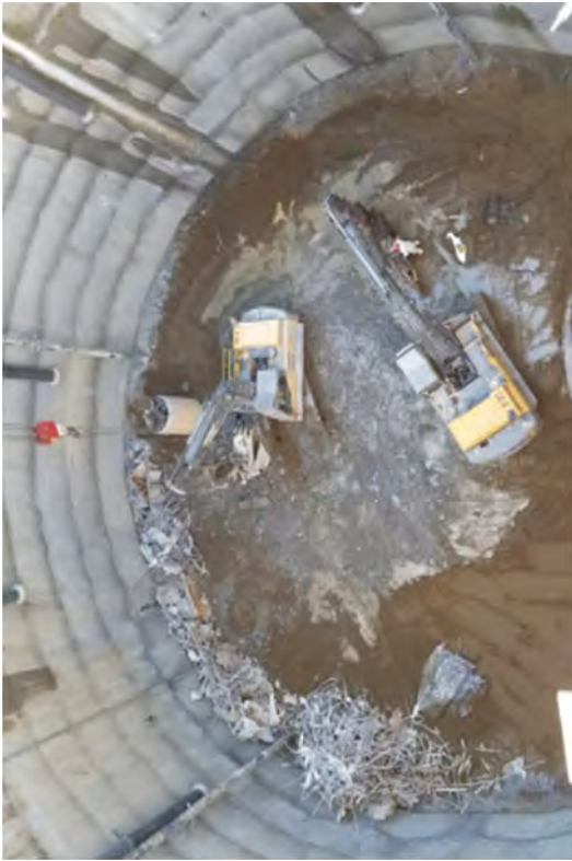
Caisson Excavation -66' EL to -70' EL
