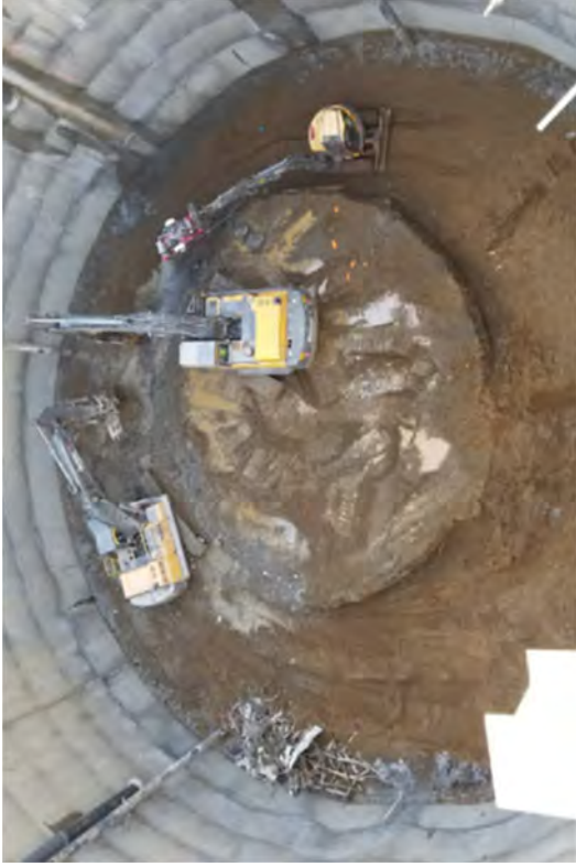
Caisson Excavation -66' EL to -70' EL
