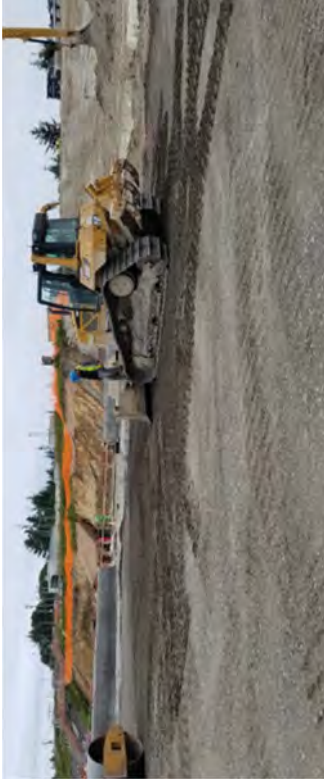
Caisson Backfill
