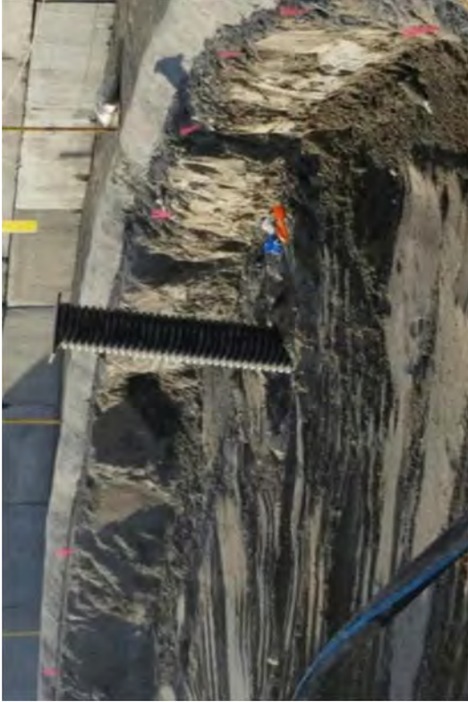
Caisson Excavation +12' EL to +8' EL
