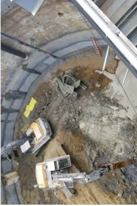
Caisson Excavation -40' EL to -46' EL
