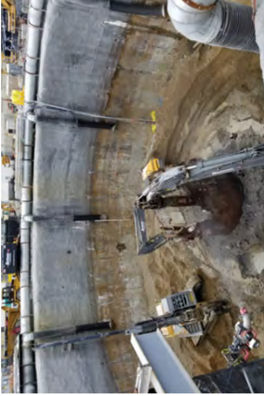
Caisson Excavation -30' EL to -34' EL
