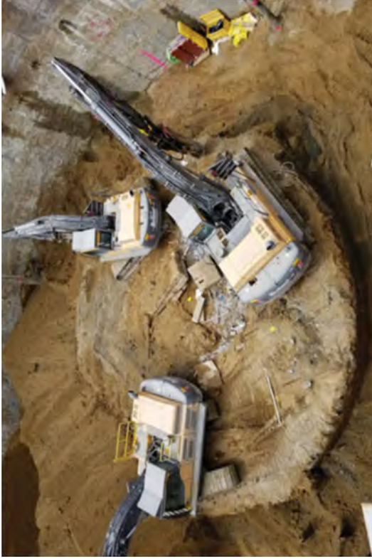
Caisson Excavation-34' EL to -40' EL
