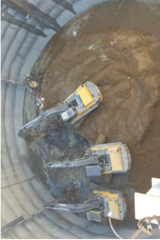
Caisson Excavation -58' EL to -66' EL
