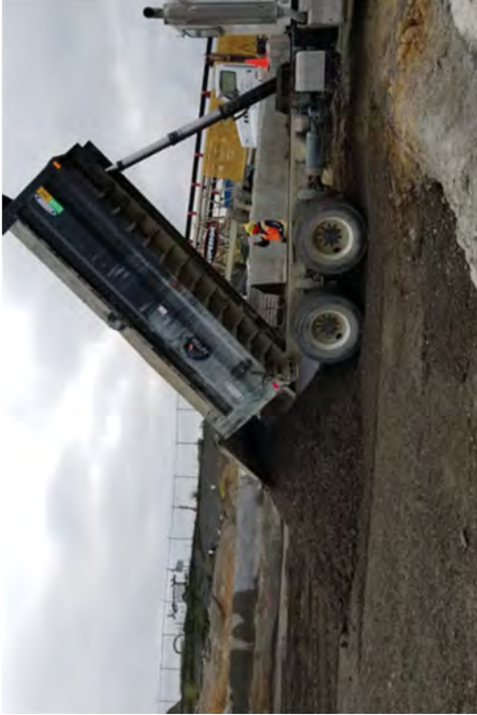
Caisson Backfill
