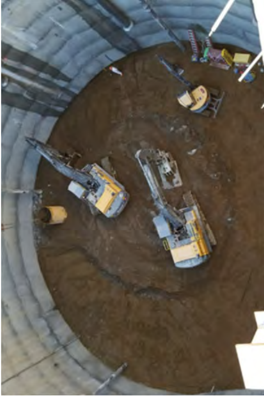
Caisson Excavation -70' EL to -76' EL
