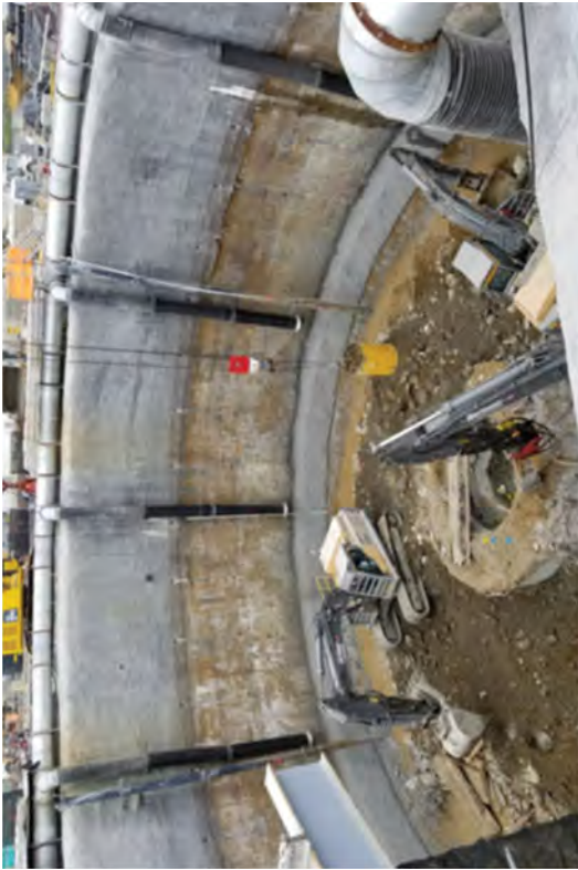
Caisson Excavation-34' EL to -40' EL
