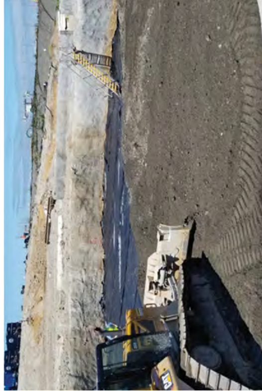
Structural backfill -0.5 / 1.5.
