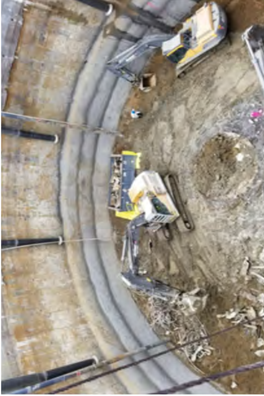
Caisson Excavation -46' EL to -52' EL
