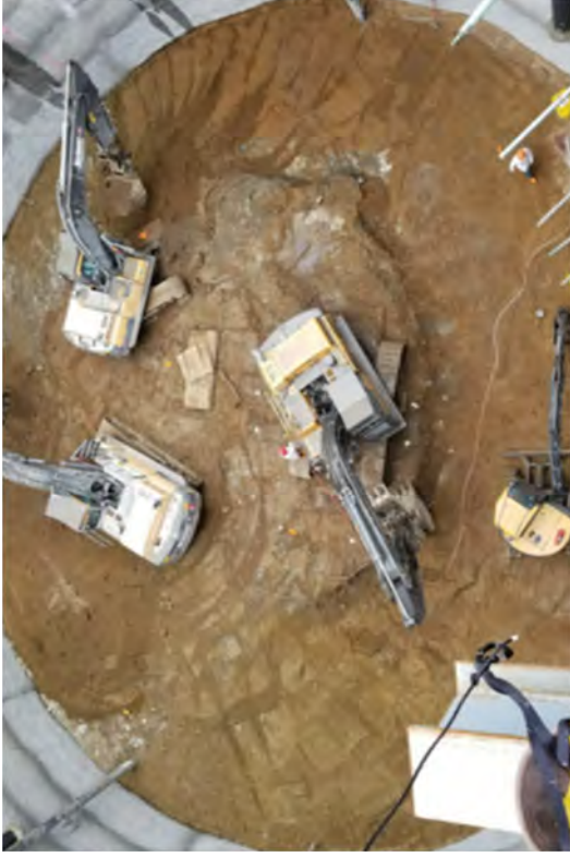
Caisson Excavation -58' EL to -66' EL
