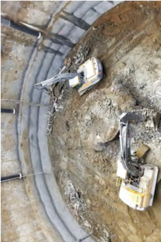
Caisson Excavation -46' EL to -52' EL
