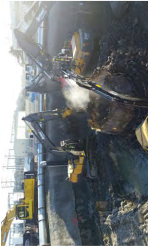
Caisson Excavation -6' EL to -10 EL
