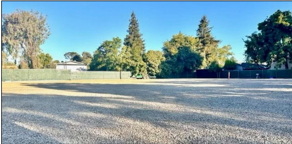
Vista del Sitio una vez finalizados los trabajos de remediación.
