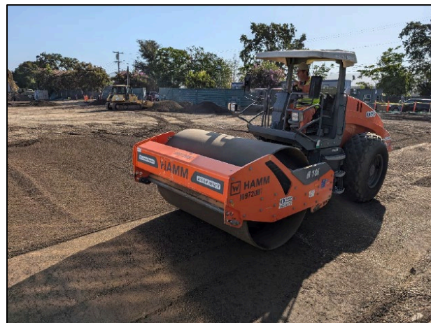
Una compactadora alisó la tierra limpia utilizada para rellenar las zonas de excavación.
