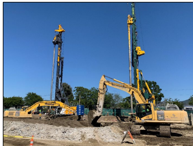
Se utilizaron perforadoras grandes para tratar los suelos más profundos en el Sitio.
