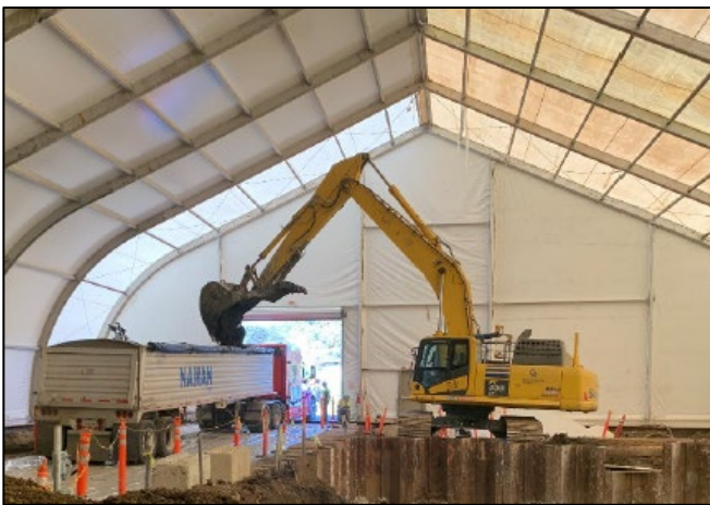
La tierra se excavó dentro de una carpa para controlar el polvo y los olores.
