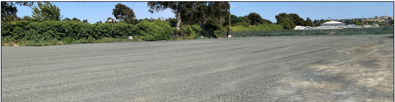
Vista del Sitio después de la remediación y restauración.
